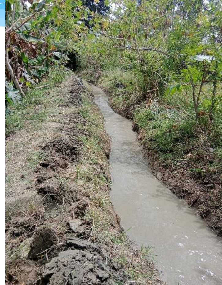
Acequia Arango durante y después de ejecución de limpieza
