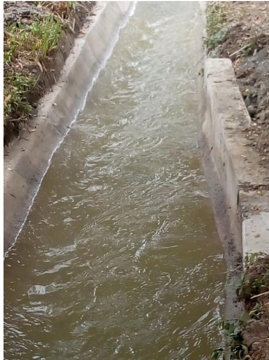
Fotos 1 y 2: Revestimiento de canal en concreto por parte de PISA S.A. en coordinación con la asociación de usuarios de "Asurtumo" sector vuelta de las feas predio Sorrento
