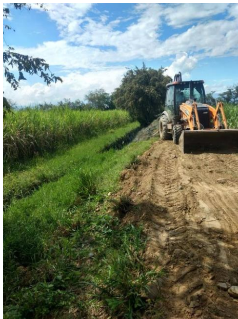
Foto 1-3: Labor de mantenimiento y reconfiguración de Canal Acequia El Hato
