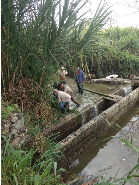
Foto 1: Personal adecuando el sitio para la reparación del canal. Trabajadores de los predios afectados.
