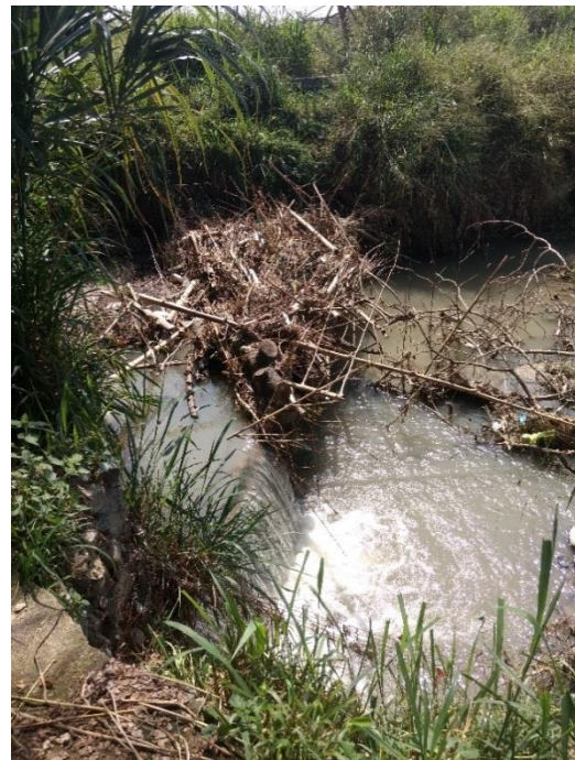
Foto 1: Canal destapado por creciente de la quebrada que se llevó las tapas Foto 2: Segunda creciente de la quebrada dejó palizada remontándola con la anterior
