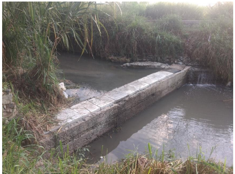
Foto 2: Tapas reconstruidas, ancladas e instaladas en el canal.
