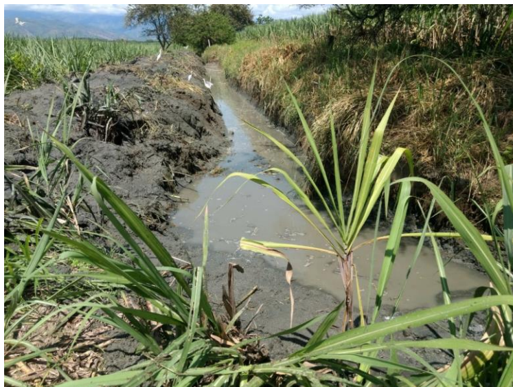
Fotos 1 y 2: Mantenimiento canal acequia el limonar
