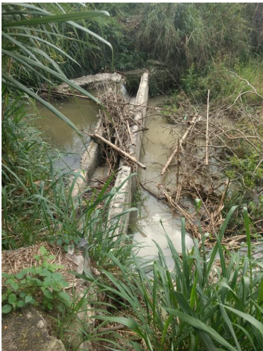
Foto 1: Canal destapado por creciente de la quebrada que se llevó las tapas Foto 2: Segunda creciente de la quebrada dejó palizada remontándola con la anterior
