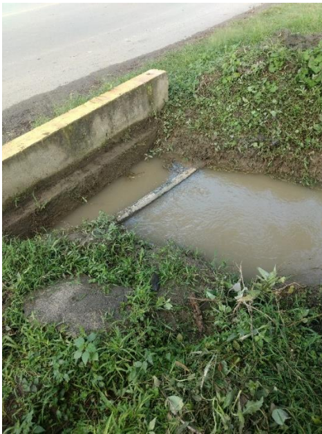
Foto 1: Sitio de desbordamiento del agua de la acequia Pekín a su paso por la vía Tuluá – Nariño por falta de mantenimiento
