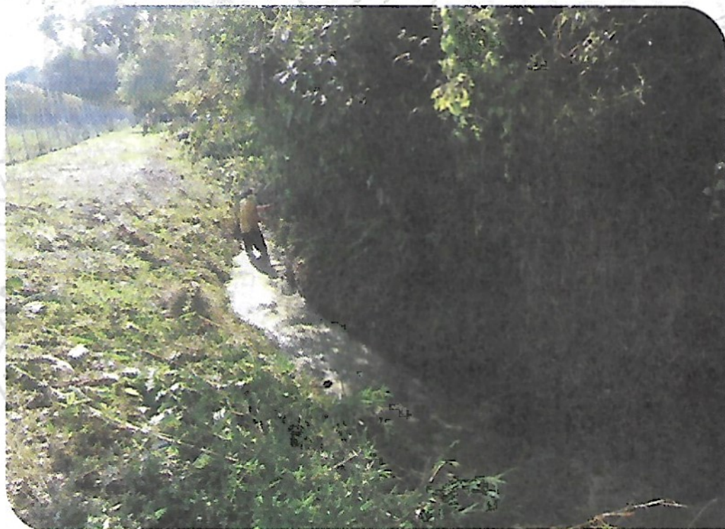
Actividad manual del mantenimiento del canal de la acequia tapias en una longitud de 340 mts.
