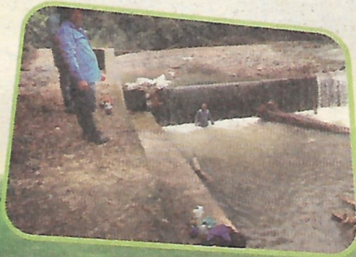
• Árbol que se retiró de la obra
