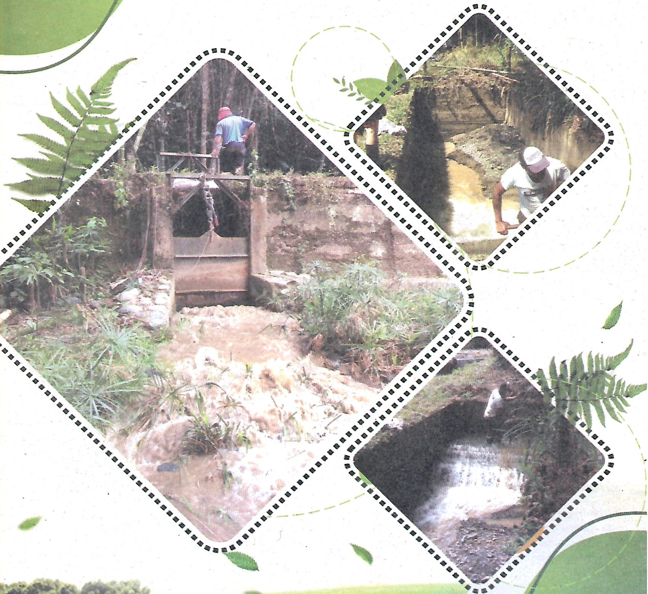
• Actividad manual del mantenimiento del desarenador del canal de la acequia Restrepo.
