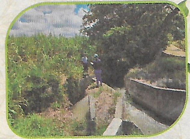
OBRA DE REPARTO ACEQUIA SAN JOSÉ
