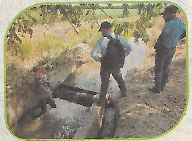
OBRA ACEQUIA SAN SEBASTIÁN
