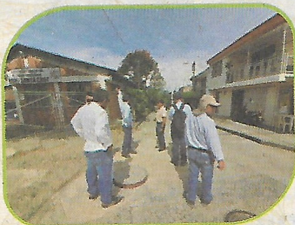
SITIO OBRA SABALETAS
